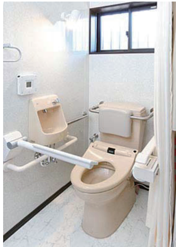
360度すべてに手すりを付けたトイレ。 これが安心のための基本。
