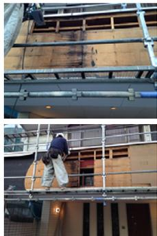
雨水の侵入によって腐食した木材はすべて交換し、防腐処理をいたしました。さらに、耐震の為に耐力壁を使って補強をいたしました。
