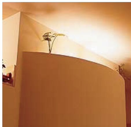
⑥洋室とトイレの同時間接照明としてシリンダー上部にアクリル板を張り、トップライトを設置
